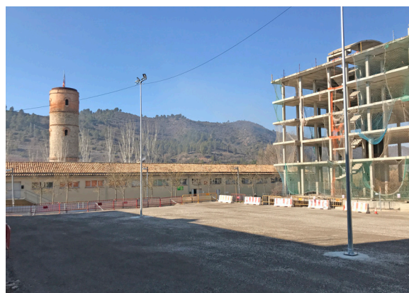
Zona d'aparcament a "contramestres" (febrer 2023)
