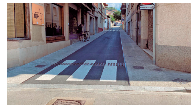
Plataforma de via única al primer tram del c/ Santa Llúcia
