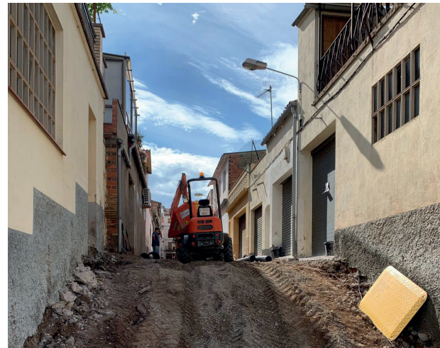
Inici de les obres al Passatge de les Vinyes
