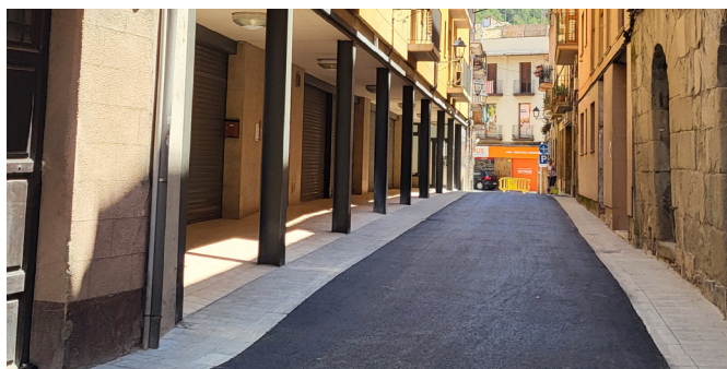
El carrer Torres Amat amb la nova pavimentació.
