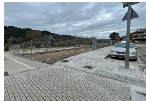
El tram urbanitzat del carrer Verge del Pilar.
