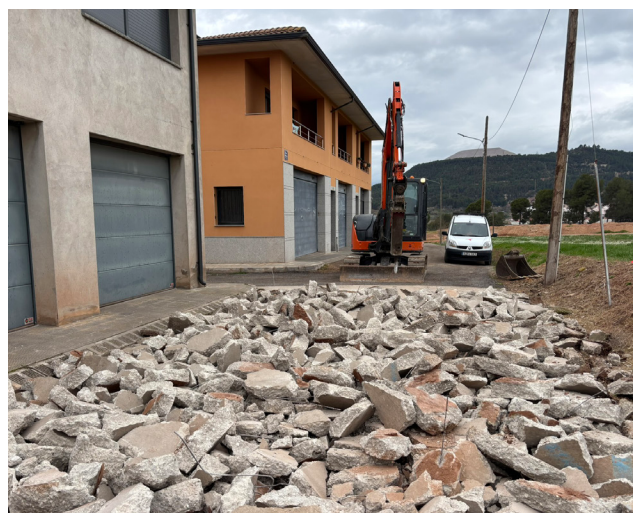
Imatge del primer dia d'obres.
