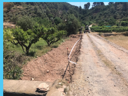
Arranjament mur camí Maiola
