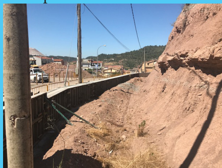
Arranjament camí de les Forques 3r tram
