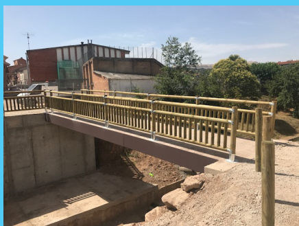
Construcció passera vianants
