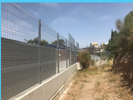
Instal·lació reixat nou col·legi Torres Amat
